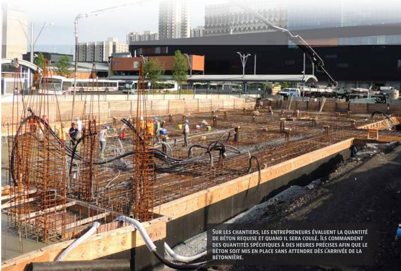
SUR LES CHANTIERS, LES ENTREPRENEURS ÉVALUENT LA QUANTITÉ DE BÉTON REQUISE ET QUAND IL SERA COULÉ. ILS COMMANDENT DES QUANTITÉS SPÉCIFIQUES À DES HEURES PRÉCISES AFIN QUE LE BÉTON SOIT MIS EN PLACE SANS ATTENDRE DÈS L'ARRIVÉE DE LA BÉTONNIÈRE.
