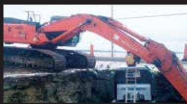
Insertion statique de ponceaux par éclatement ou « static pipebursting ».
