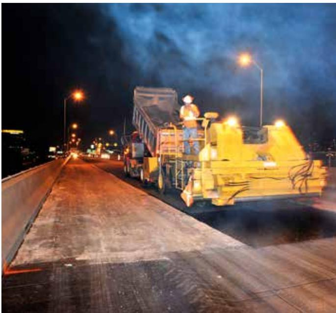
LE PROCÉDÉ PEUT ÊTRE APPLIQUÉ EN COUCHE SIMPLE, DOUBLE, VOIRE TRIPLE, SELON L'ÉTAT DES FONDATIONS PORTANTES ET L'INTENSITÉ DE LA CIRCULATION; MAIS AUSSI SUR DES ROUTES EN GRAVIER, UN TRAITEMENT DE SURFACE EXISTANT OU UN ENROBÉ BITUMINEUX VIEILLISSANT.
