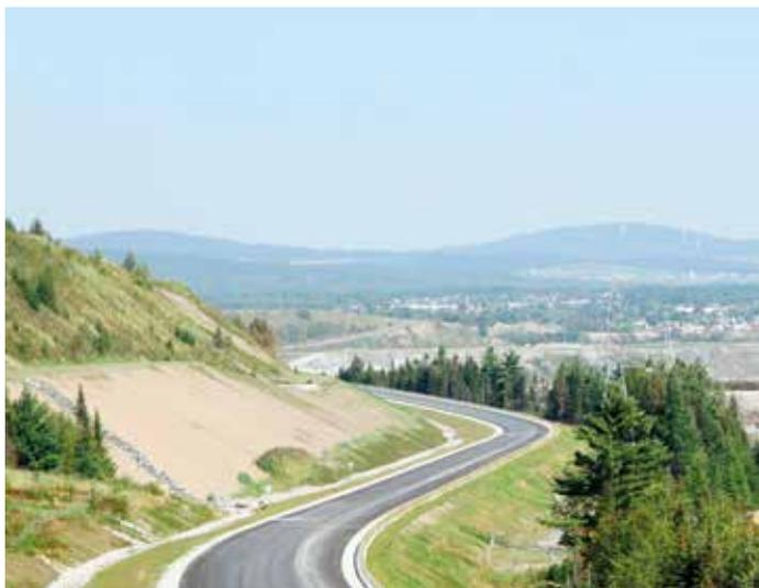
LA RELOCALISATION DE LA ROUTE 112 A NÉCESSITÉ LA CONSTRUCTION D'UNE NOUVELLE ROUTE DE 10,3 KM, DE DEUX À QUATRE VOIES, SELON UNE TOPOGRAPHIE VALLONNÉE OÙ LES HALDES MINIÈRES ATTENANTES ONT ÉTÉ STABILISÉES ET LE FOND DE LA ROUTE APLANI. Crédit : MTQ
